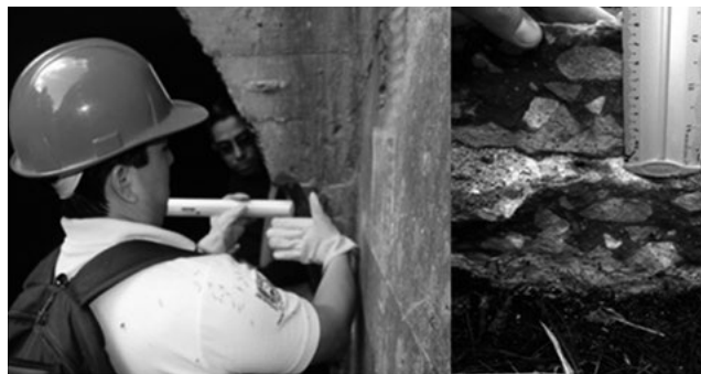
Figura 13. Medición del frente carbonatado (zona incolora,) en la entrada y salida del Túnel
