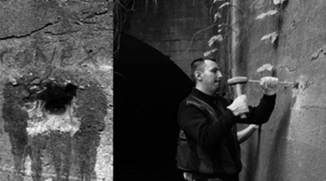
Figura 8. Acero de refuerzo localizado a 8 cm de profundidad sobre alero de entrada del Túnel
