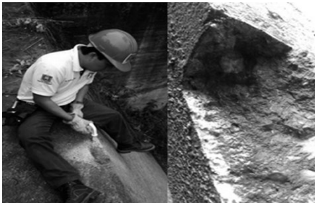
Figura 12. Pruebas de carbonatación en la entrada y salida del Túnel
