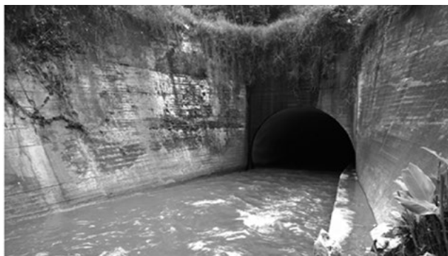
Figura 4. Vista de la infraestructura de Entrada del Túnel
