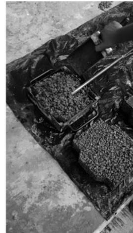
Figura 2. Elaboración de los adoquines con grava de 3/8
