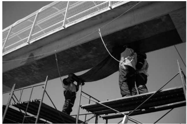
Figura 7. Colocación de fibras de carbono en puentes de estructura de concreto.
