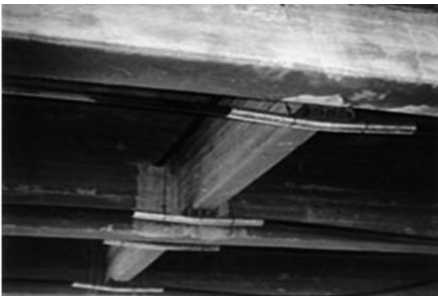
Figura 6. Colocación de postensado desadherido en puentes de estructura de concreto.
