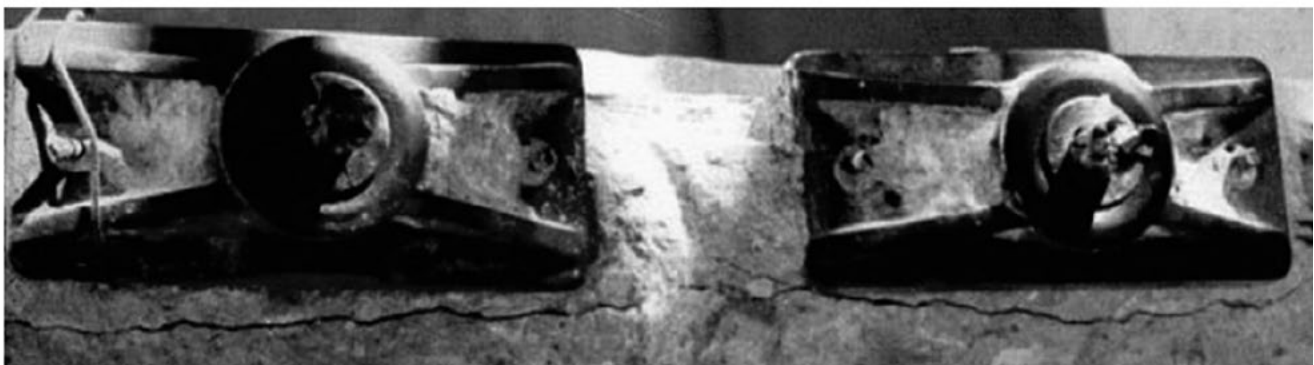
Figura 4. Daño por corrosión en viga de concreto postensada (Emmons, 2005).
