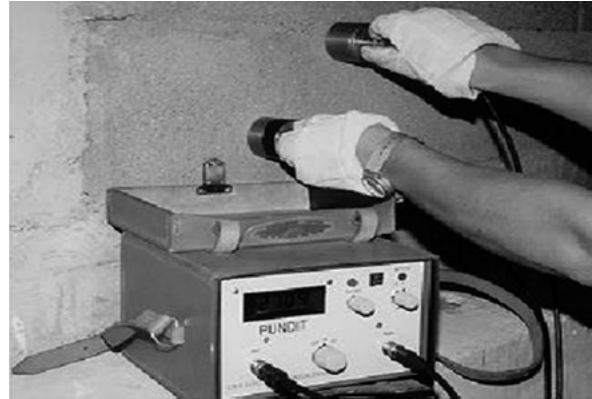
Figura 5. Verificación de la eficiencia de la inyección de grietas.
