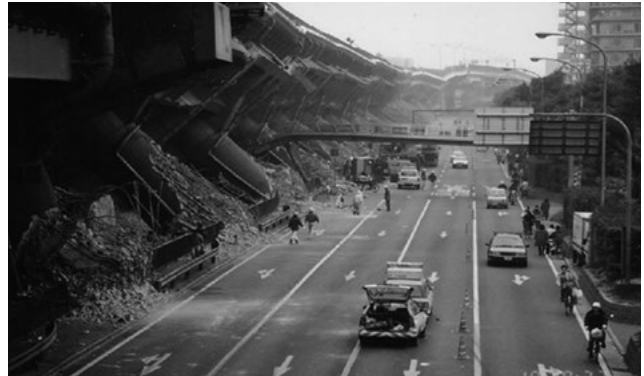
Figura 3. Daño en la autopista Hanshin, tras el sismo de Kobe, Japón en 1994 fallaron 18 pilas (Kawashima, 2000).
