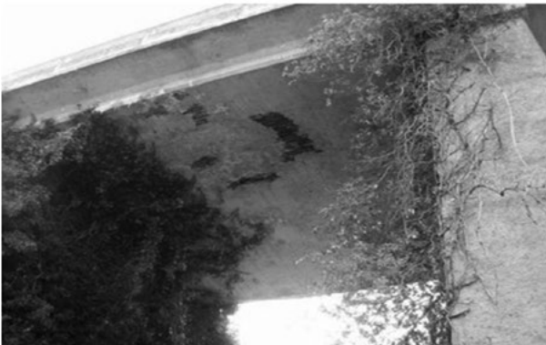
Figura 2. Falta de mantenimiento en puente, donde se aprecia crecimiento de vegetación, corrosión y carbonatación.
