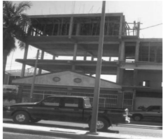
Figura 2. Ejemplos de estructuras con piso blando, adicionalmente problemas de cambio brusco de rigidez y masa en la ciudad de Tuxtla Gutiérrez, Chiapas.
