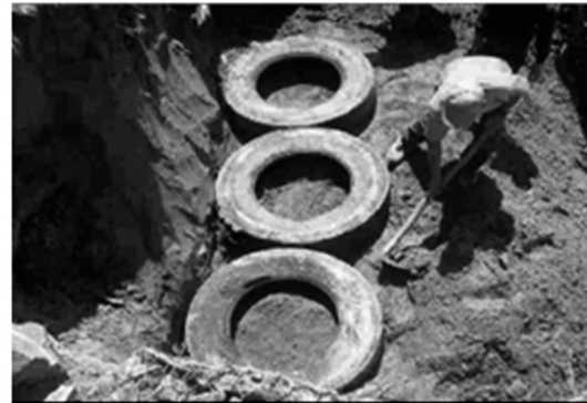
Figura 3. Conformación y Nivelación del terreno (ref. 6)
