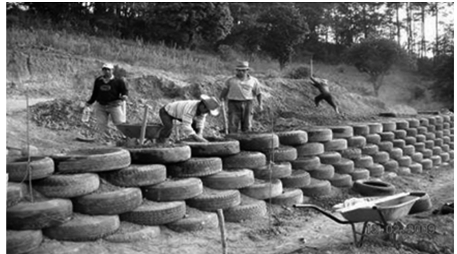
Figura 7. Muro de contención a base de neumáticos (ref. 7).
