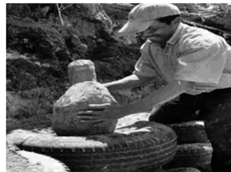
Figura 5. Relleno y compactación de llantas (ref. 7)
