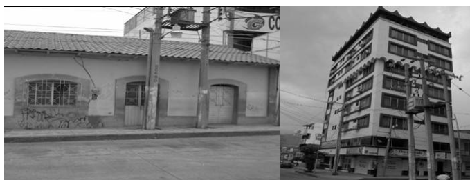
Figura 2. Ejemplos de dos de los edificios analizados, estructura muraria de ladrillo (izquierda) y de marcos de CR con cerramientos de ladrillo (derecha).
