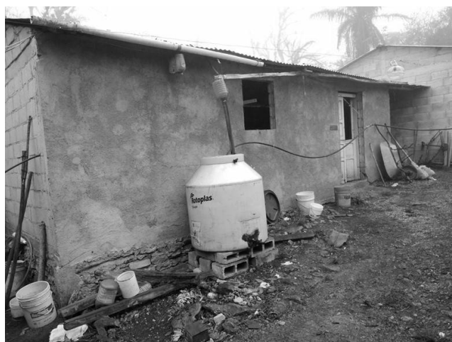
Figura 3. Colección de agua de lluvia de forma rudimentaria en Santa Martha
