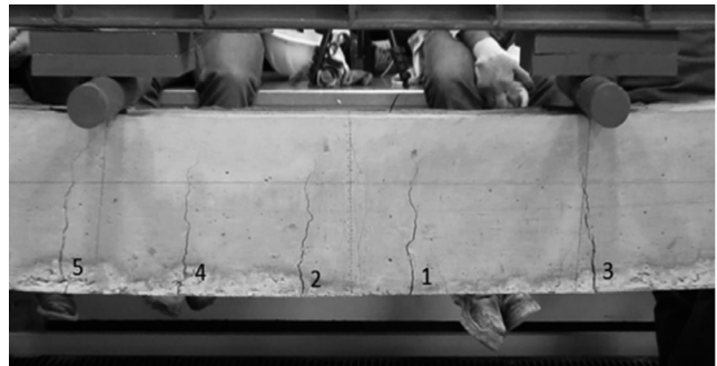
Figura 7. Secuencia del agrietamiento
