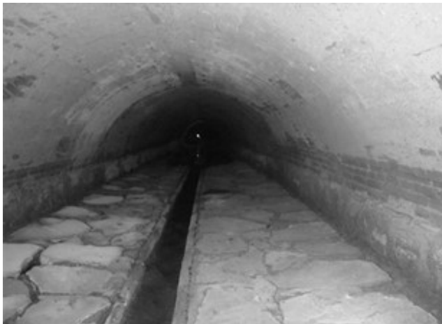
Foto 1. Embovedado con estribos de mampostería de piedra y arco bóveda de ladrillo (Mundo, 2019a)
