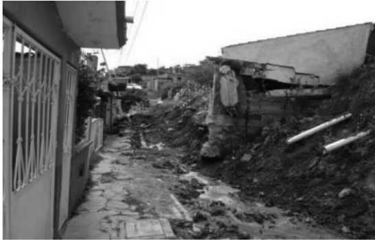
Figura 3. Deslizamiento del talud en condiciones saturadas (Ordóñez J. 2014)
