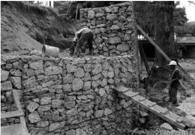
Figura 3. Muro de gavión (Cruz & Hernández, Noviembre 2012).
