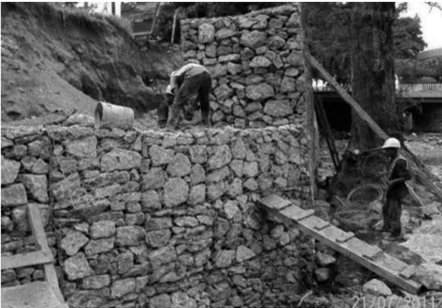
Figura 3. Muro de gavión
