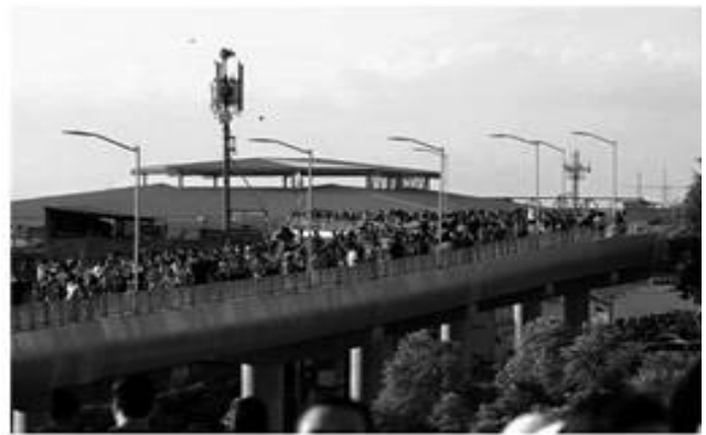
Figura 3. Puente peatonal del estadio Rayados, Nuevo León, México http://www.posta.com.mx/nuevo-leon/abriran-puente-bailarin-juego-rayados-vs-chivas
