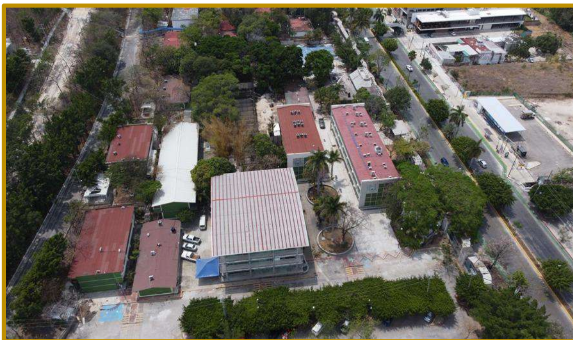
Imagen 66: Fotografía satelital de la Facultad de Ingeniería Campus I
